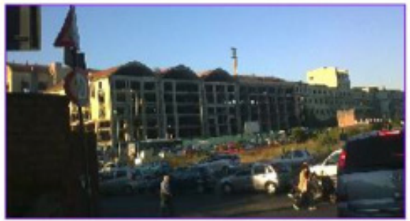
EDIFICIO DISMESSO Via Tiburtina
