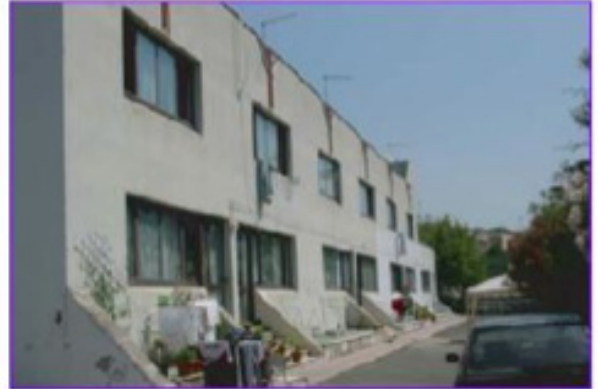
EDIFICIO SCOLASTICO Tor Sapienza
